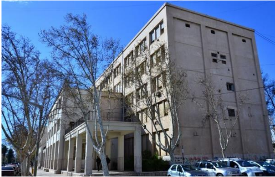
Edificio 9 de Julio.
