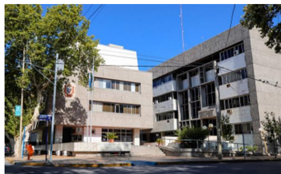
Edificio de la Municipalidad de la Capital.
